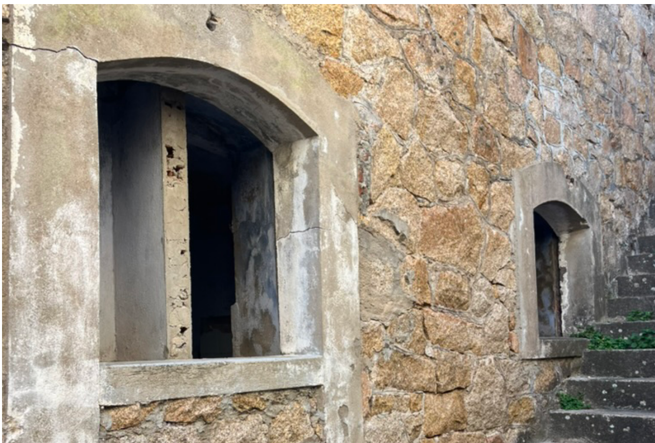
Figura 3: Due aperture sulle quali montare i nuovi infissi
