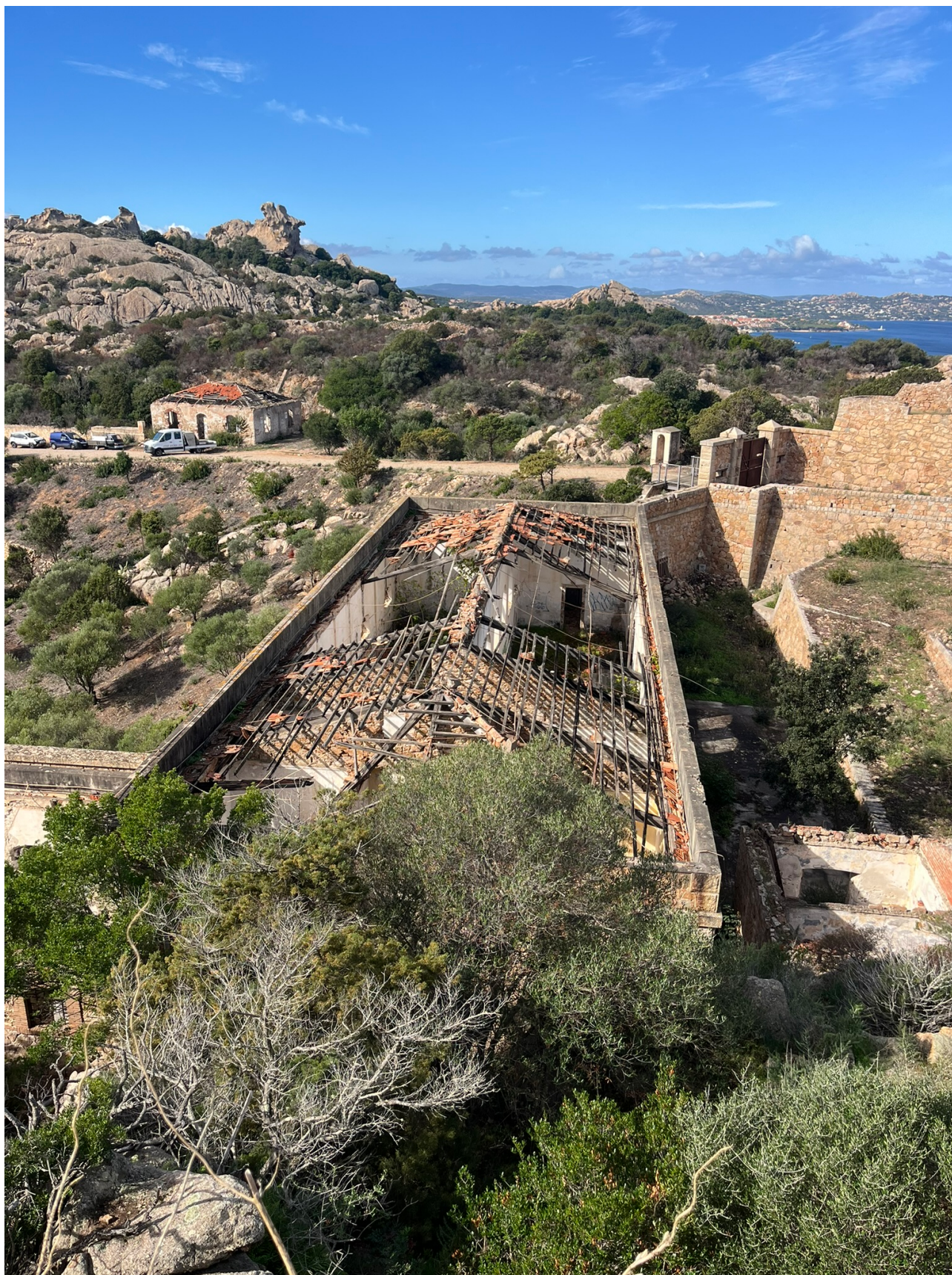
Figura 6: Stato attuale delle coperture dei dormitori
