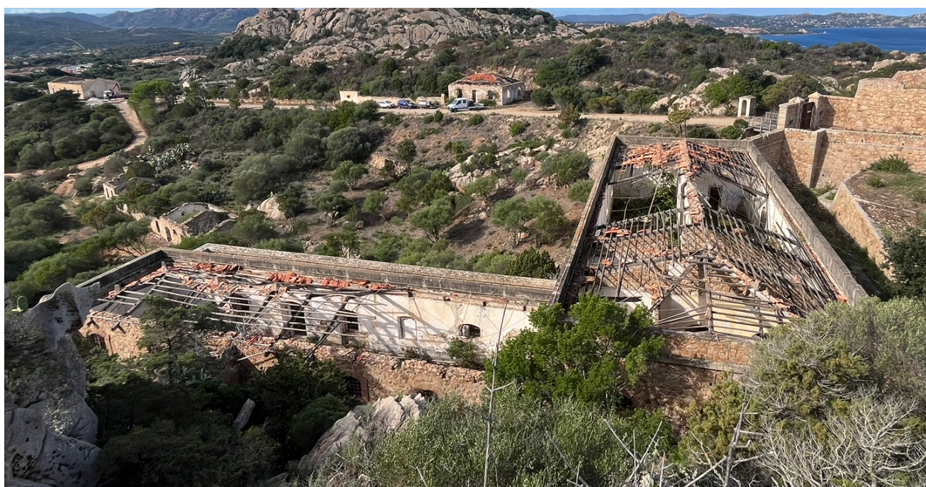
Figura 5: stato attuale coperture dei dormitori e della casa del comandante
