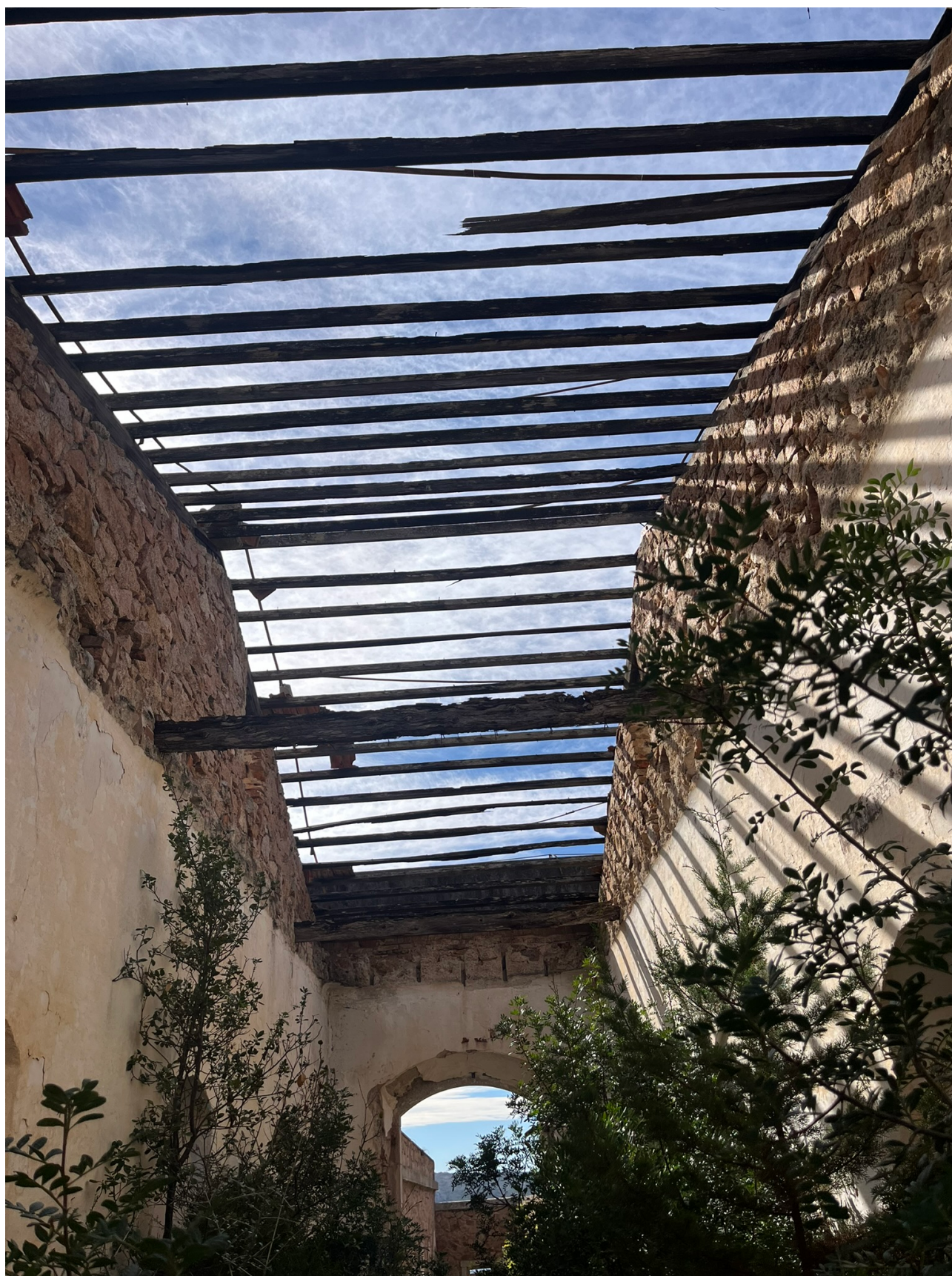
Figura 7: Dettaglio coperture dei dormitori
