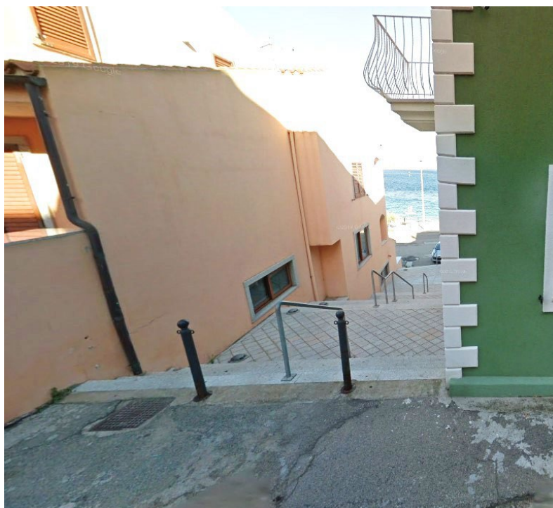
Foto 4 - Corrimano e paletti dissuasori esistenti in Via Mazzini
