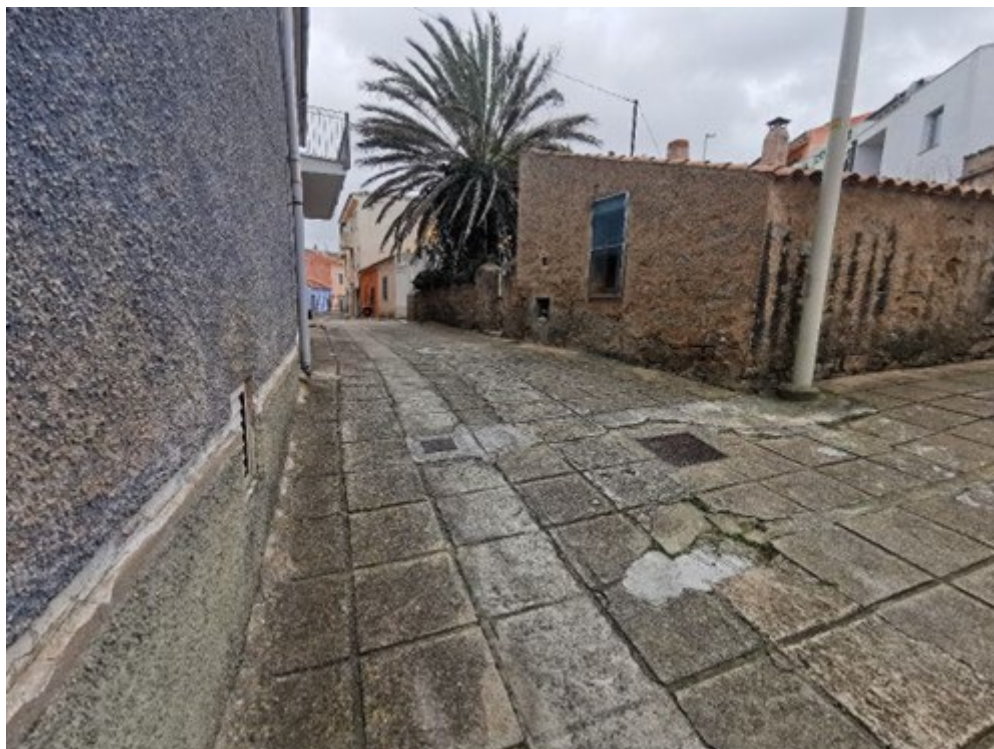
Foto 6 - Via Scuole Vecchie stato attuale
