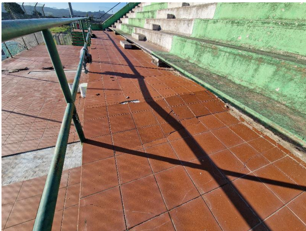
Foto 1 - La pavimentazione della tribuna.
