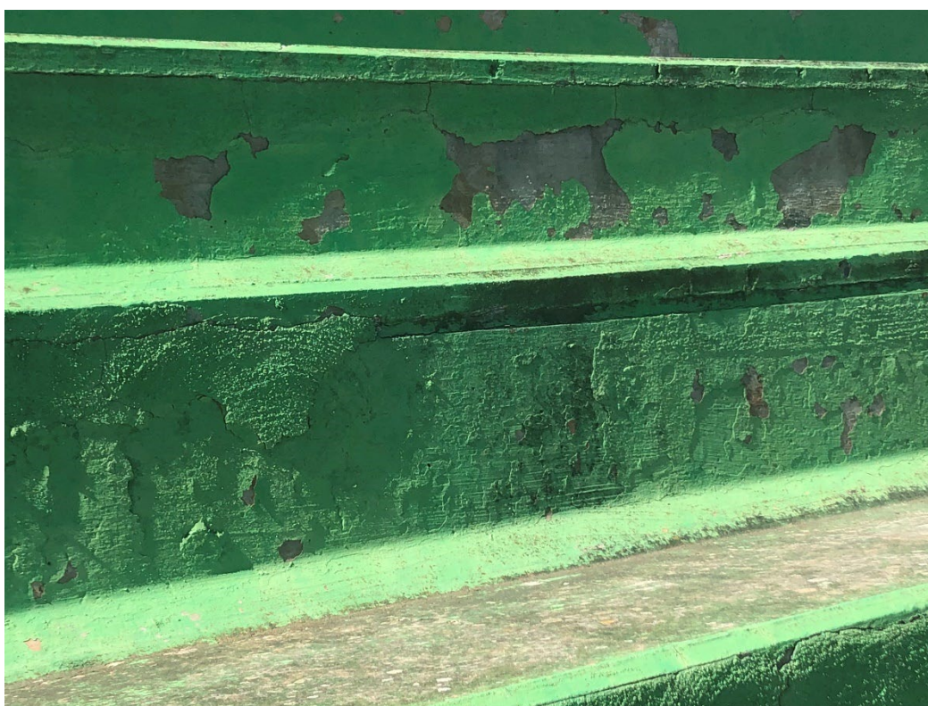
Foto 4 - I giunti orizzontali tra le sedute in cemento della tribuna
