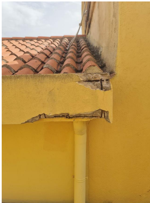
Dettaglio tetto camera mortuaria
