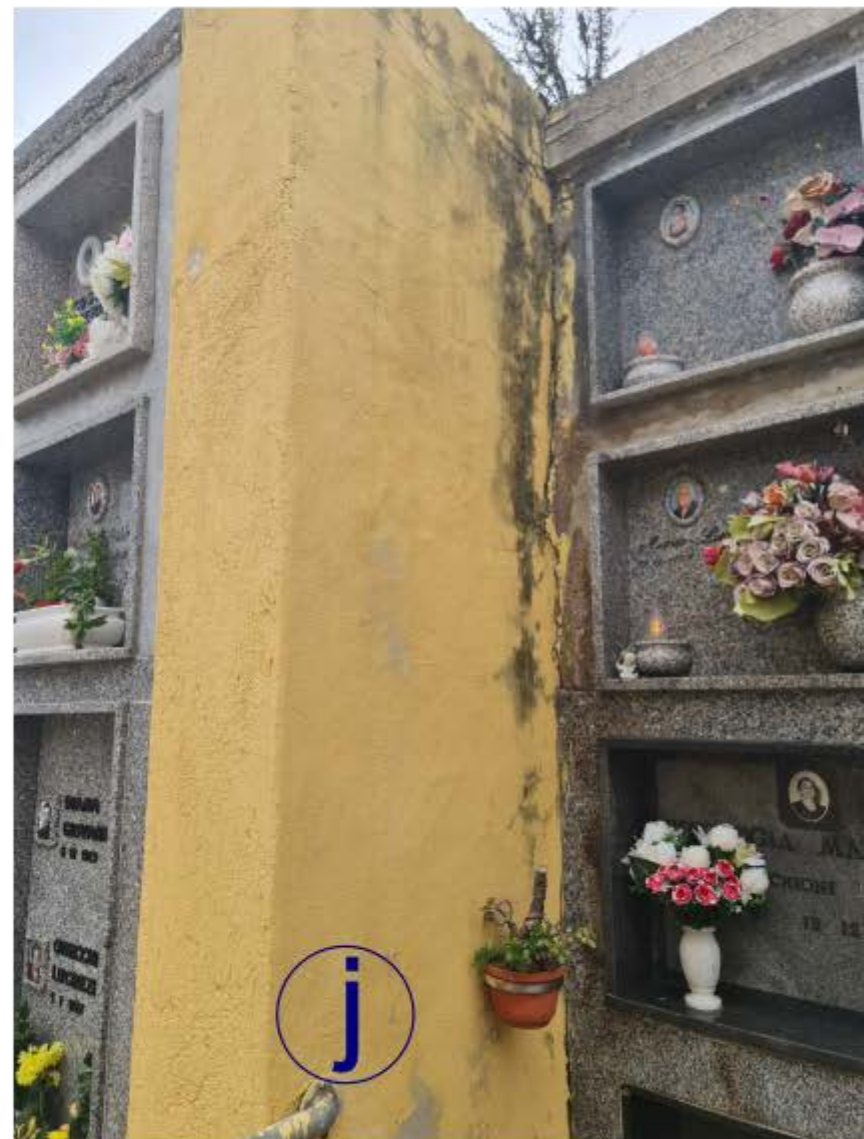
Pulizia dalle parti ammalorate, rifacimento intonaco (stimata nel 30% del totale) e tinteggiatura parete
