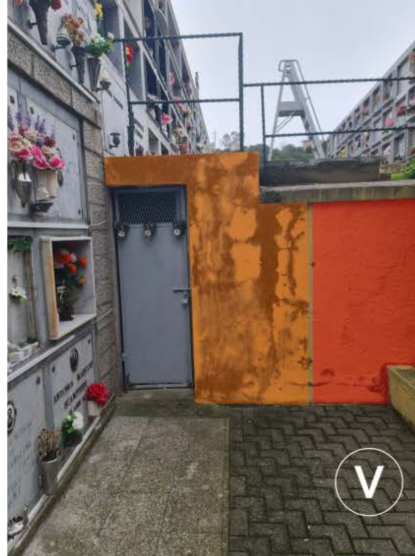
Rifacimento intonaco attorno alla porta di ingresso al magazzino e trattamento antimuffa e tinteggiatura parete sino alle scale in granito
