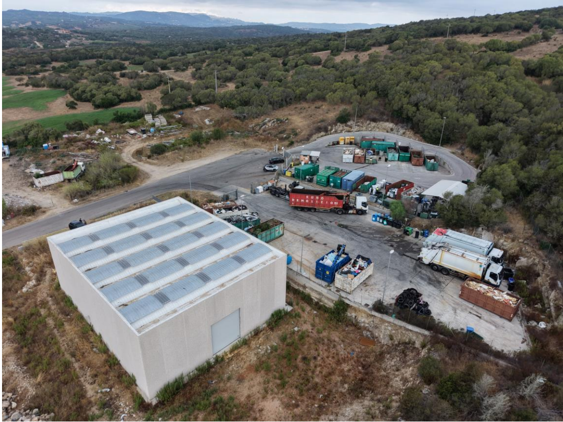
Foto 5 – Stato di fatto
