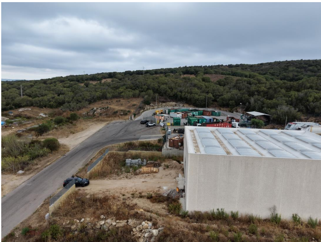
Foto 3 – Stato di fatto
