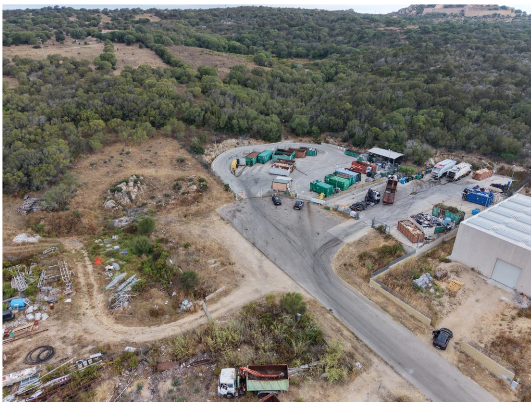
Foto 1 – Stato di fatto
