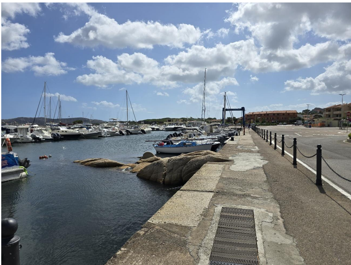
Rappresentazione fotografica dello Stato di fatto
