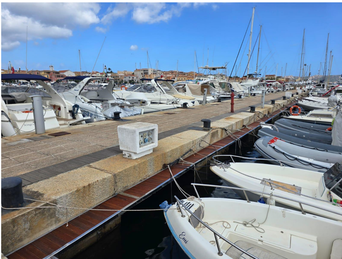
Rappresentazione fotografica dello Stato di fatto
