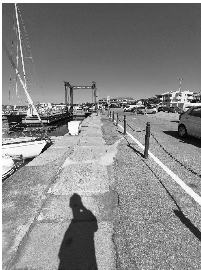
Figura 1 - Vista della zona di intervento
