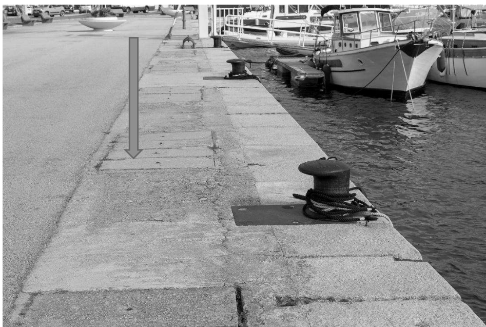
Figura 2- Particolare delle attuali coperture del condotto dei servizi
