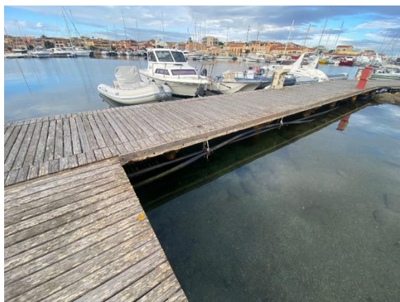
Dettaglio Passerella su pali darsena est oggetto di intervento
