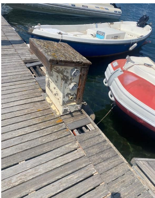
Dettaglio piano di calpestio e impianti esistenti
