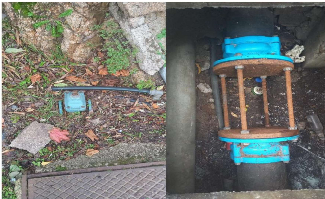
Fig. 5 Tubazione idrica in PE a vista
