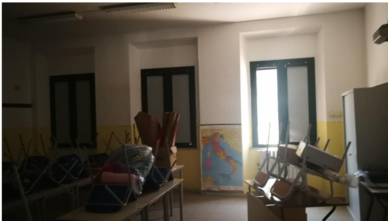
Muratura portante perimetrale
