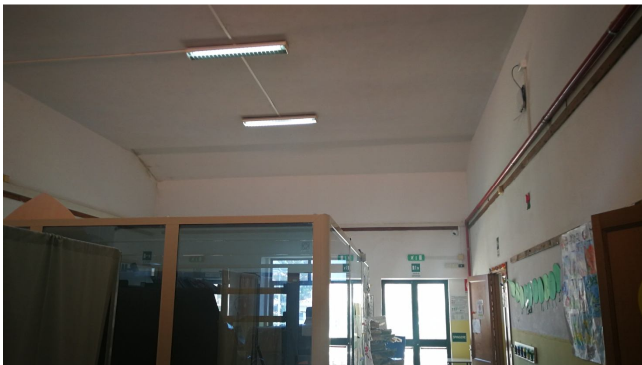
Solaio di copertura
