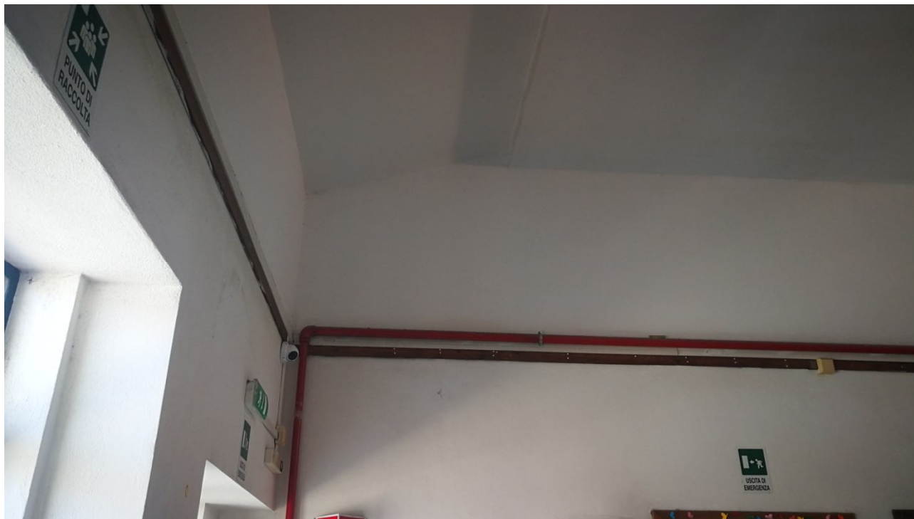
Solaio di copertura
