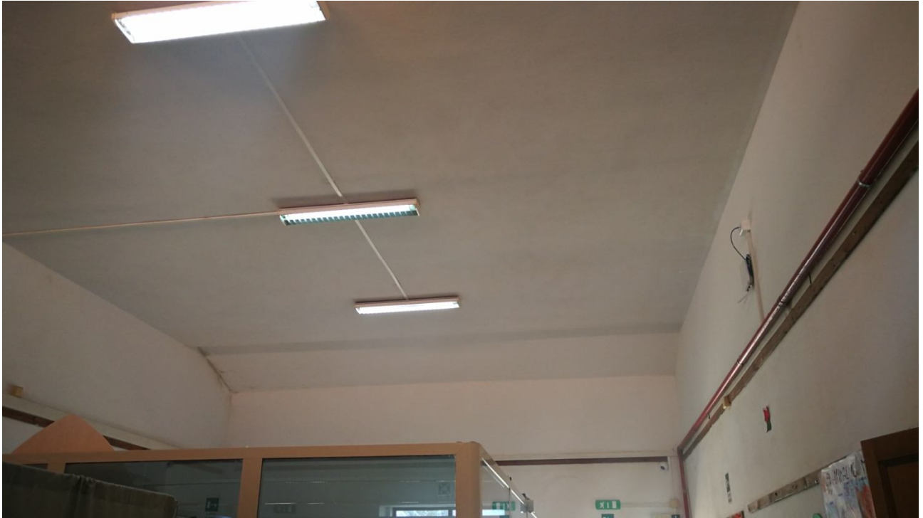
Solaio di copertura
