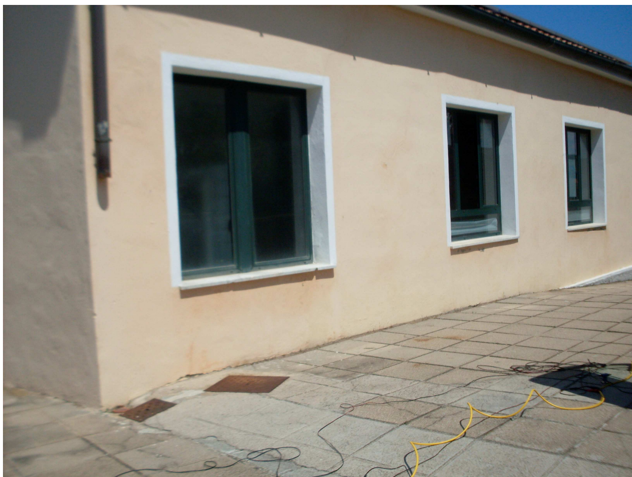
FOTO N°61 Vista su spigolo SW 2 lato S
