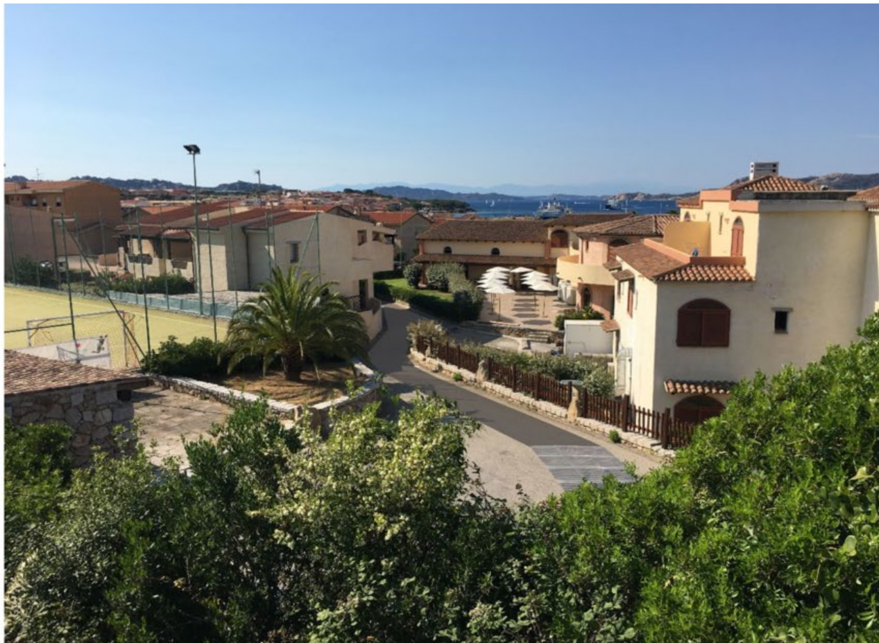
POST OPERAM 1 - Via Capo d'Orso – vista via del Vecchio Marino
