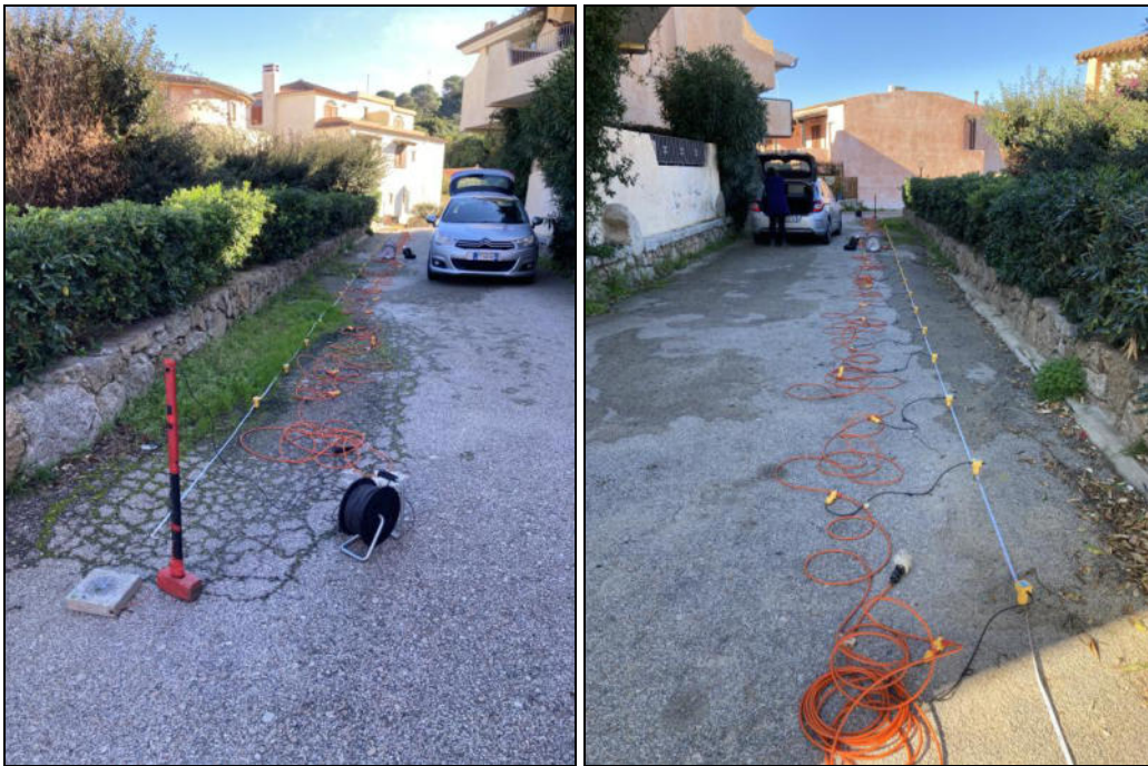
Figura 9. Panoramica stendimento n.3.
