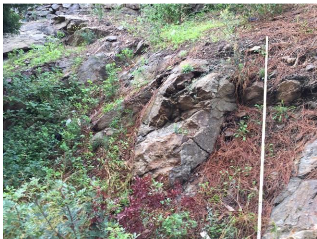
Figura 7 Diatessiti litoidi affioranti a monte dell'area di intervento
