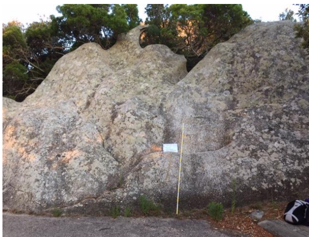
Figura 18. Stazione strutturale SS2 in prossimità della scuola media (Canale Baragge)
