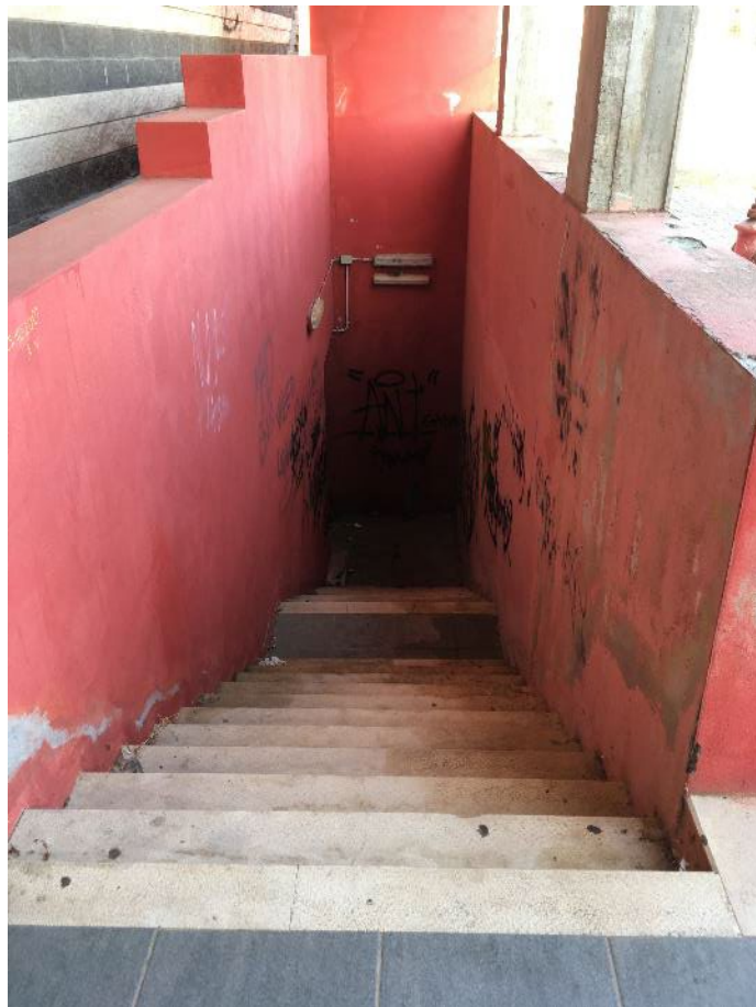
Foto 13 - Vano scale verso locali interrati lato Montiggia
