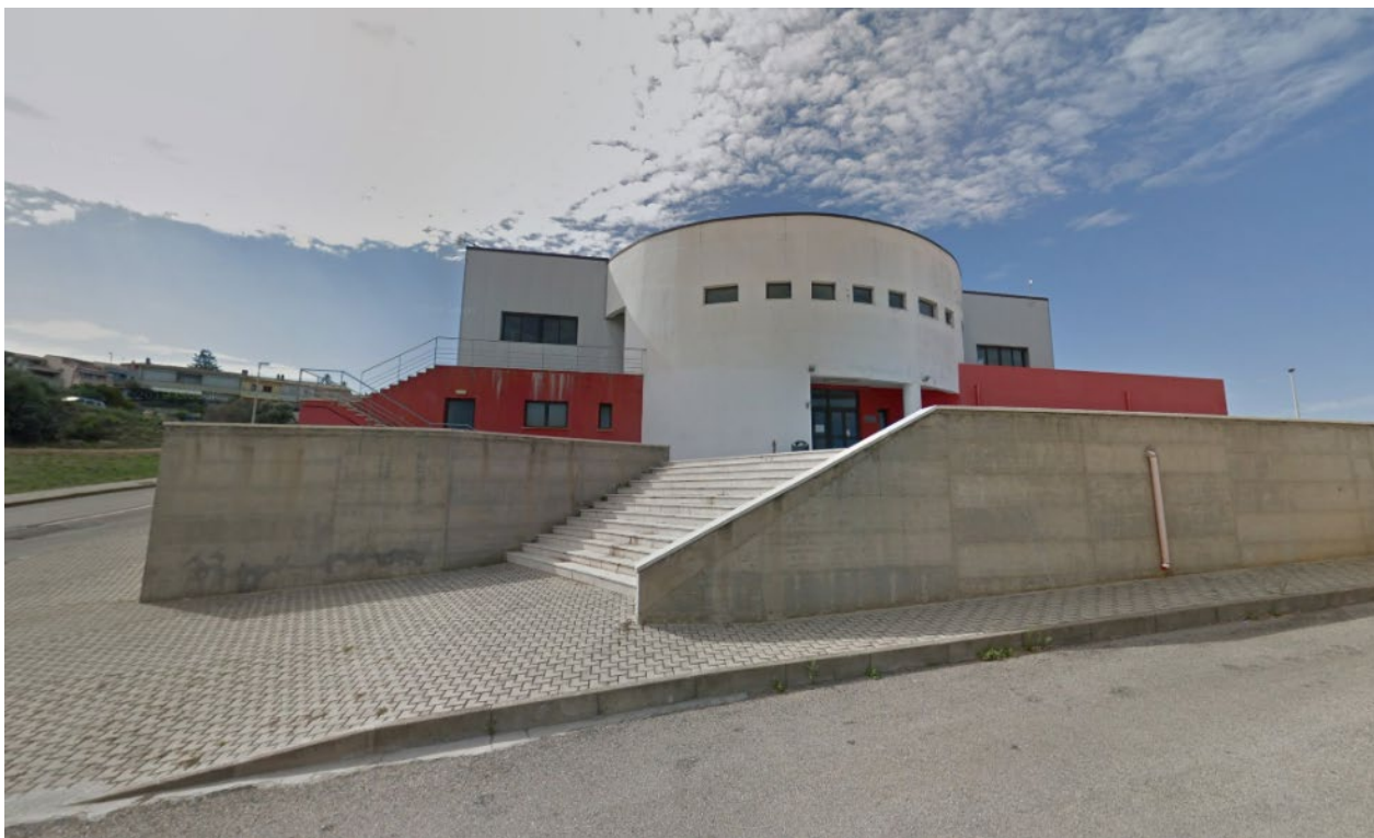
Foto 1 - Prospetto principale Palazzetto dello Sport
