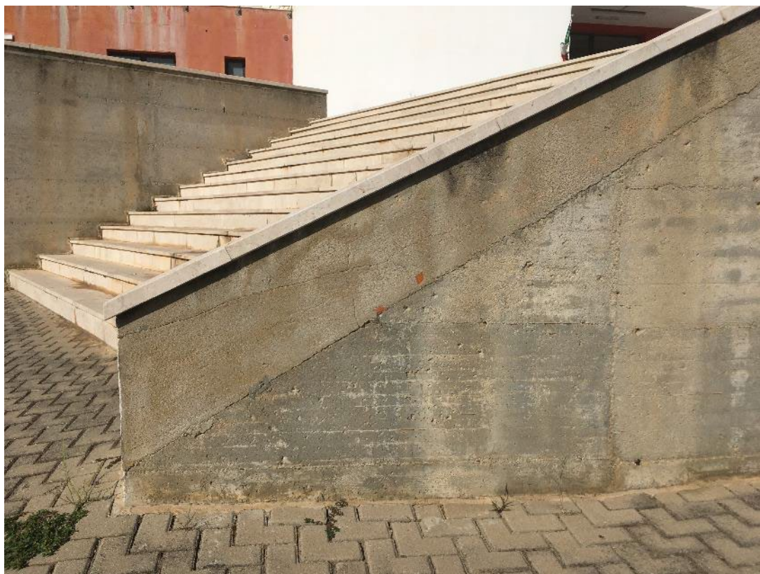
Foto 2 - Dettaglio del calcestruzzo a vista
