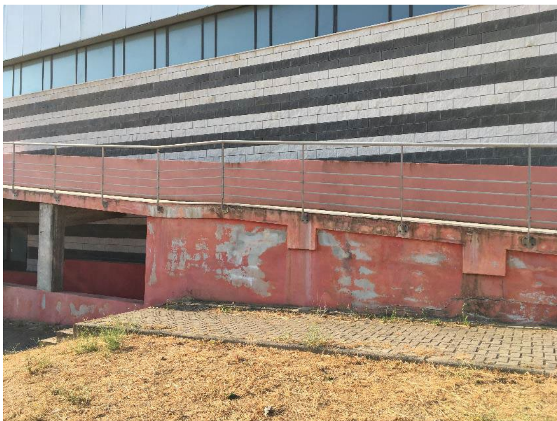
Foto 12 - La rampa sul lato Montiggia
