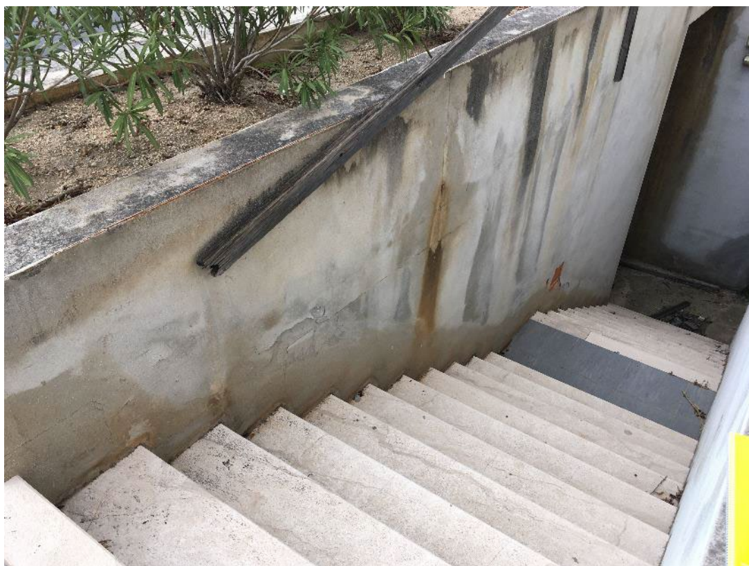
Foto 8 - Dettaglio vano scale lungo Via delle Ginestre
