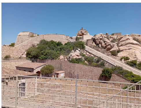
Batteria Monte Altura
