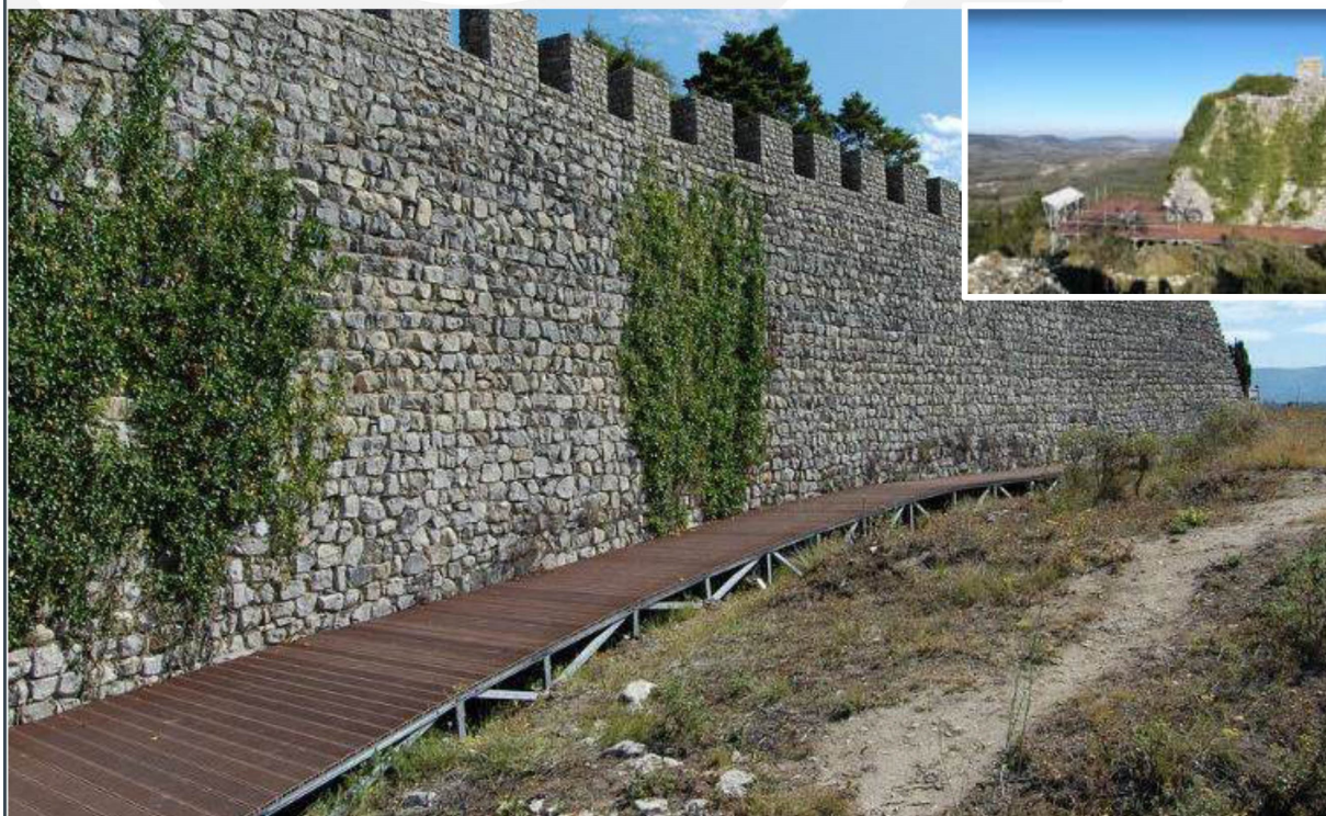
Esempi do passerella in legno composito realizzati in siti sensibili
