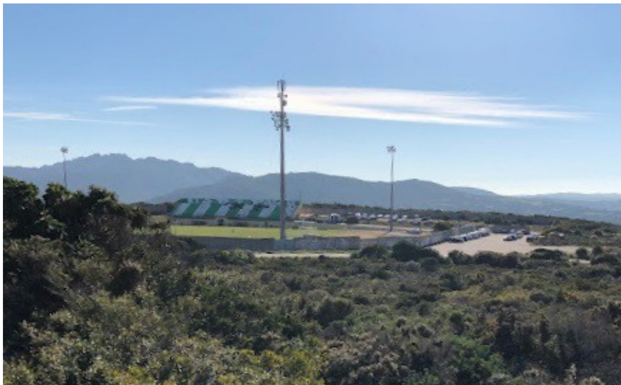
Vista allo stato attuale dal pianoro antistante la strada provinciale 121
