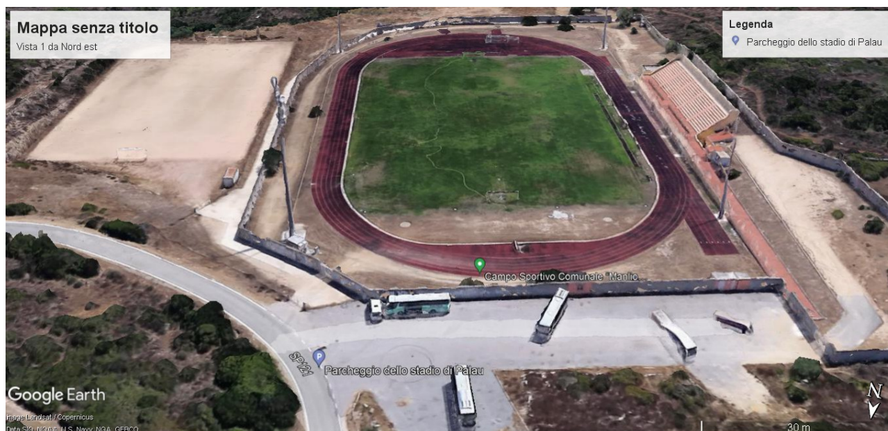
L'impianto nello stato attuale, vista verso Sud, in primo piano parcheggio
