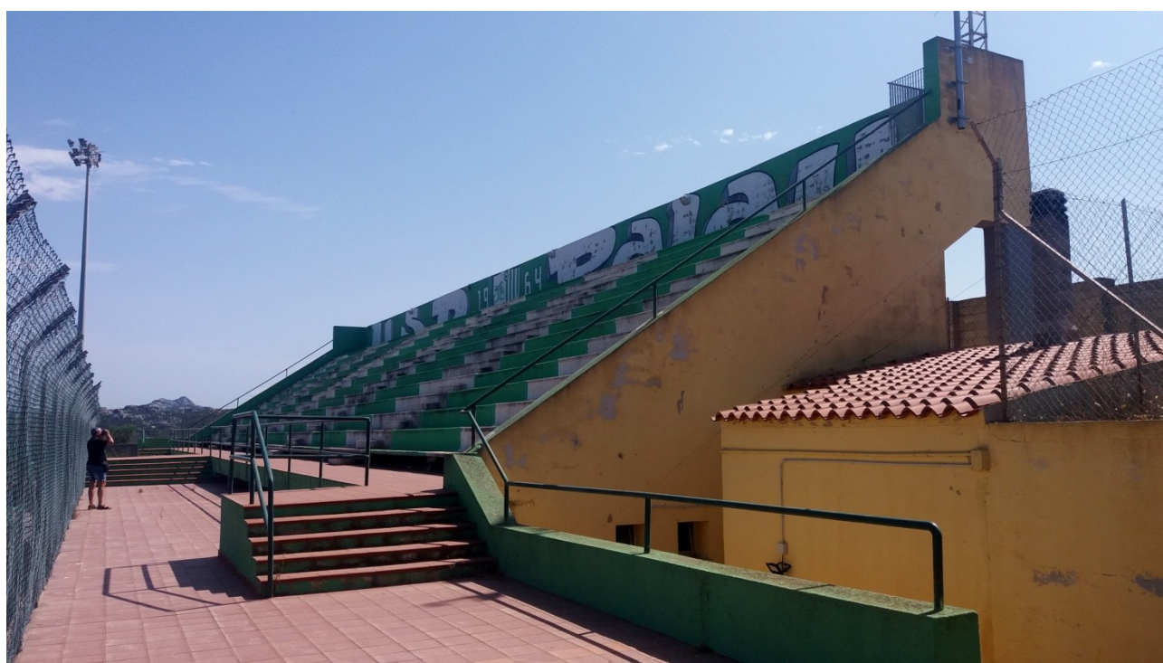
Fig. 7 – vista della tribuna verso SUD EST
