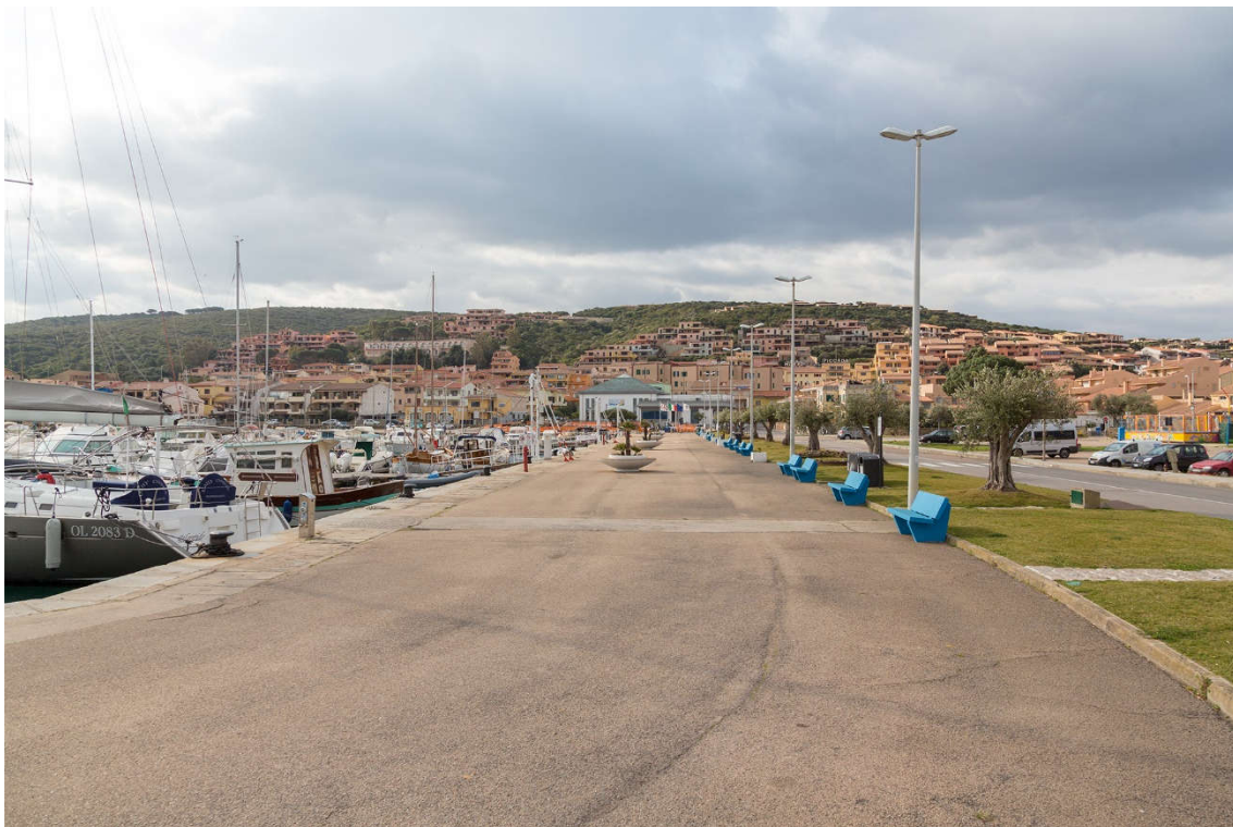
Rappresentazione fotografica dello Stato di fatto
