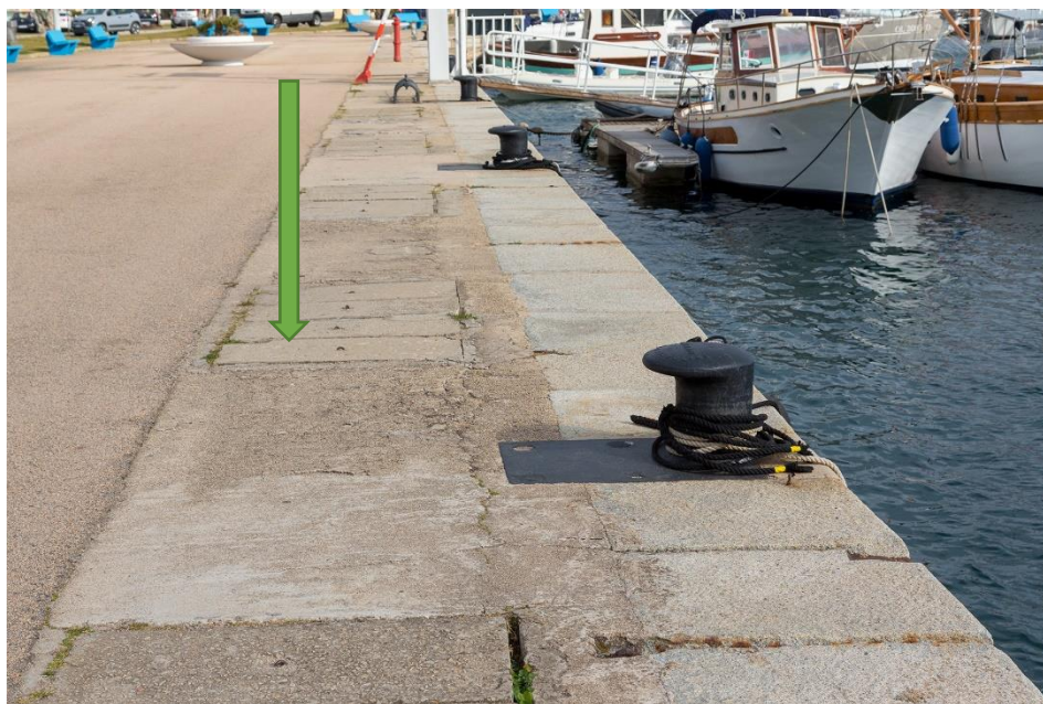
Figura 3- Particolare delle attuali coperture del condotto dei servizi
