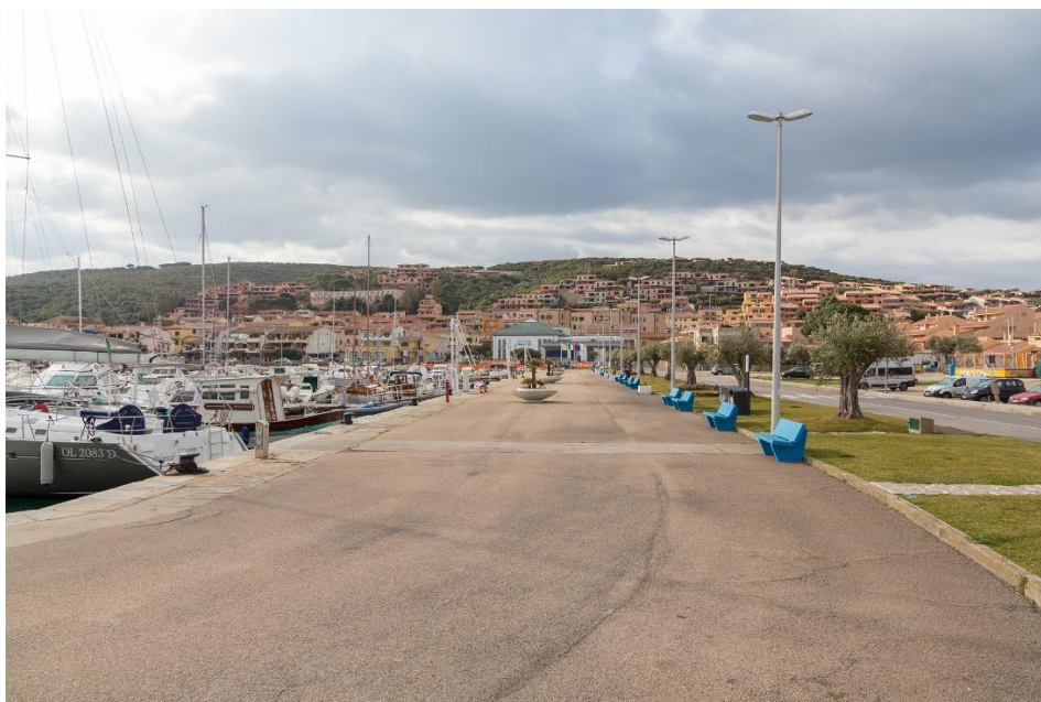
Figura 2 - Vista della zona di intervento
