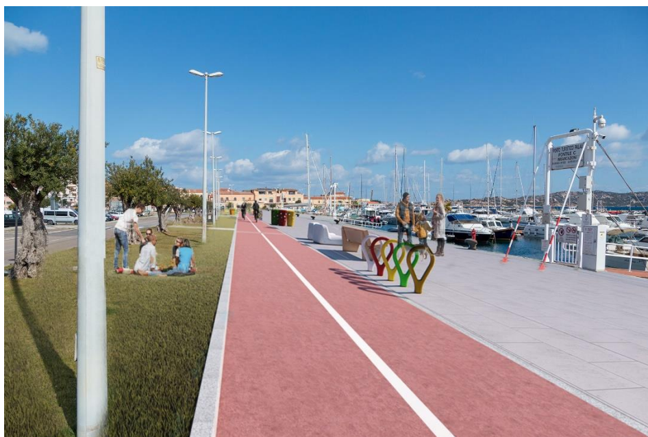
Figura 8 – Vista dalla pista ciclabile di nuova realizzazione
