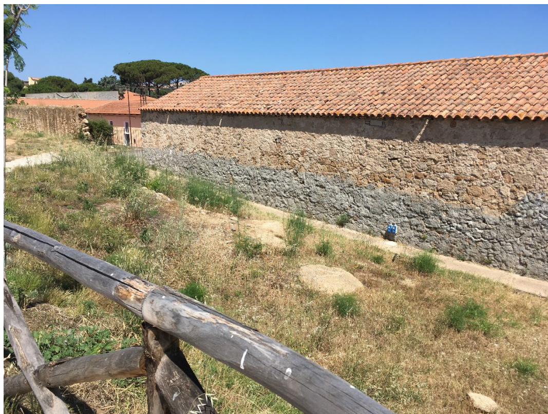
Foto 5 - Vista angolo nord ovest
