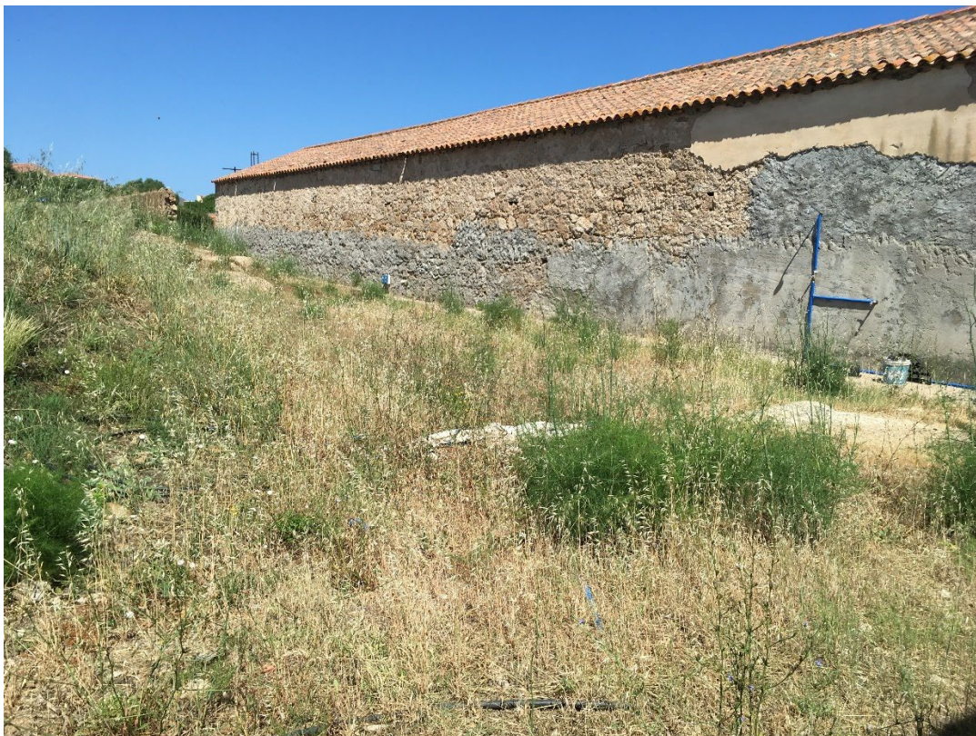
Foto 1 - Panoramica dell'area a ovest
