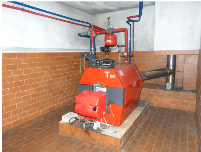
Foto 8 Vista della centrale termica esistente con caldaia a gasolio
