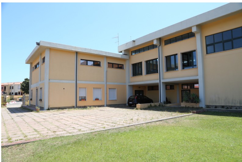
Foto 2 vista dal fronte sud - ingresso palestra
