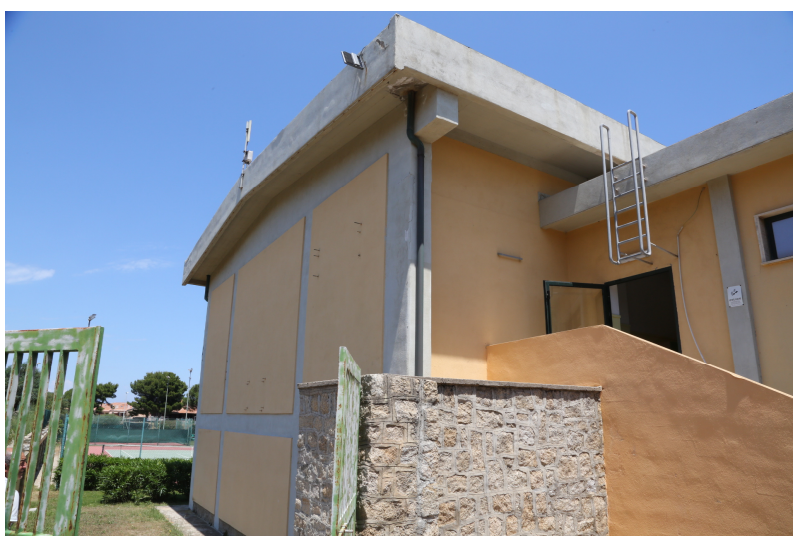
Foto 4 vista dal fronte ovest - ingresso laterale / uscita di sicurezza
