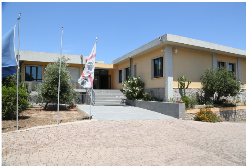
Foto 1 Vista dell'edificio dal fronte sud su ingresso principale
