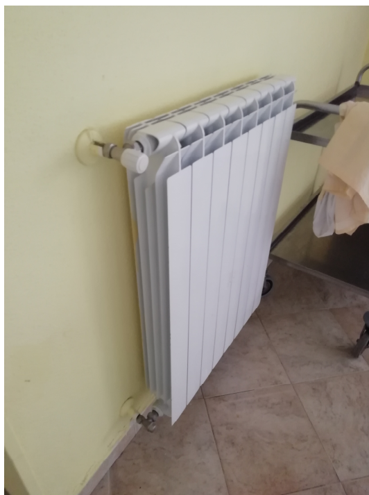
Foto 12 radiatore tipo esistente in alluminio
