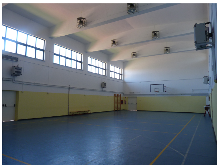
Foto 13 Aerotermini esistenti asserviti alla palestra
