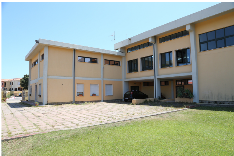
Foto 2 vista dal fronte sud - ingresso palestra
