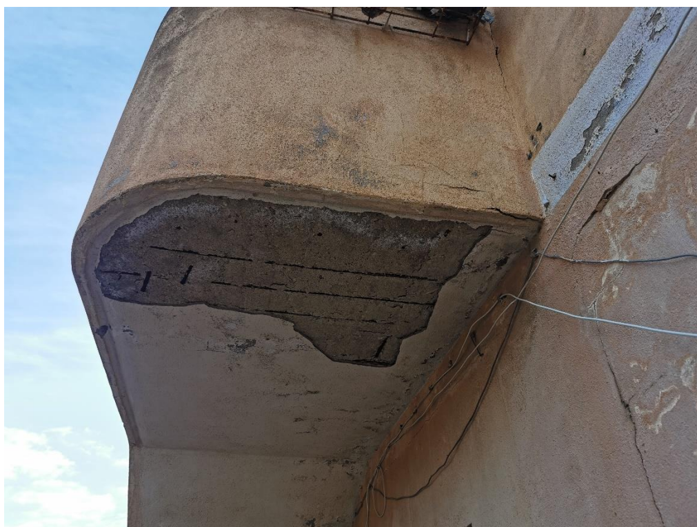
Foto 14 - Dettaglio della scala esterna
