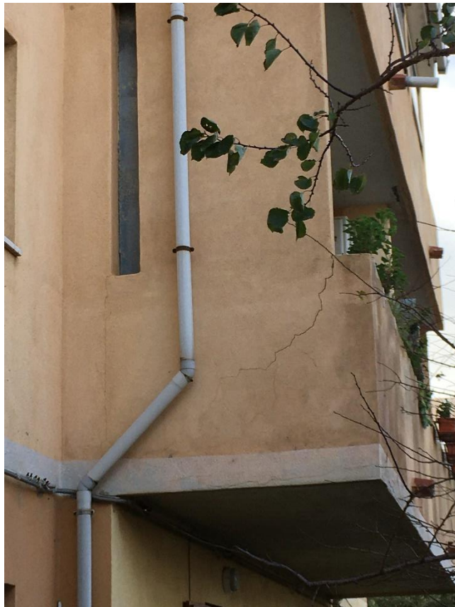
Foto 10 - Dettaglio di balcone
