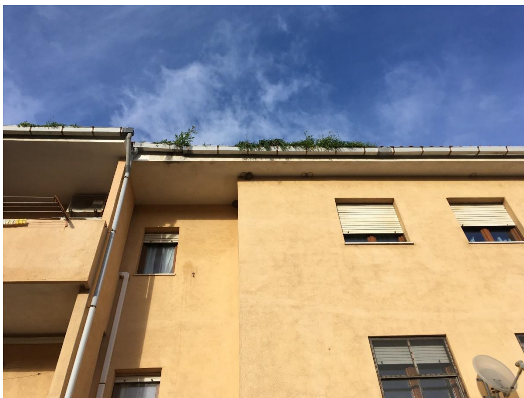
Foto 6 – Dettaglio dei canali di gronda
