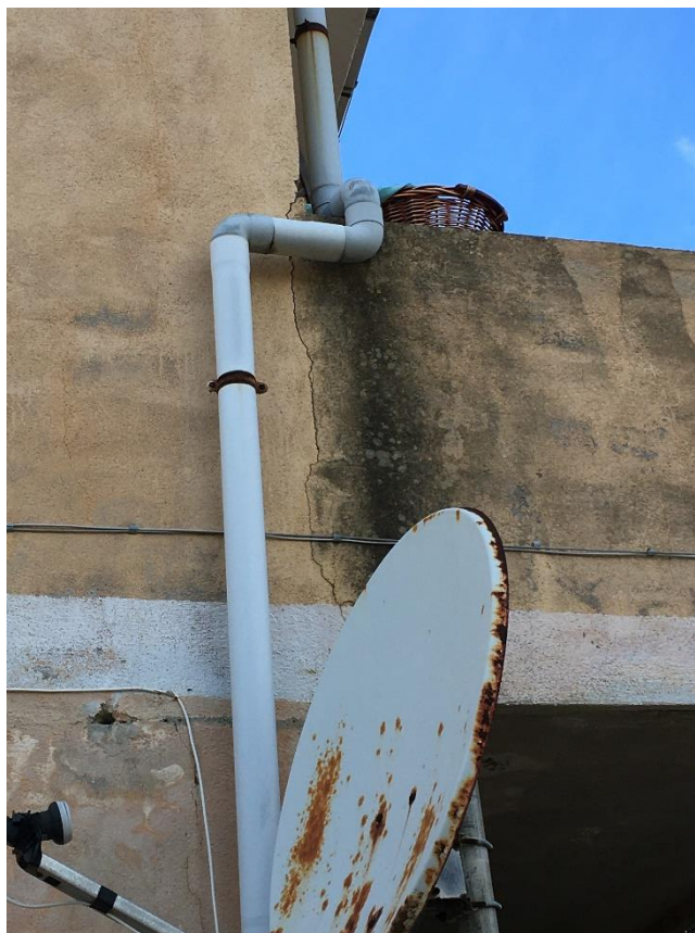
Foto 11 - Dettaglio di balcone
