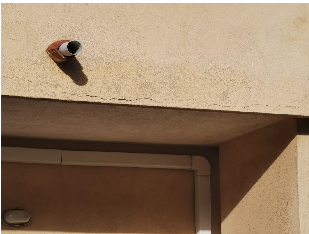
Foto 16 - Dettaglio dei balconi
