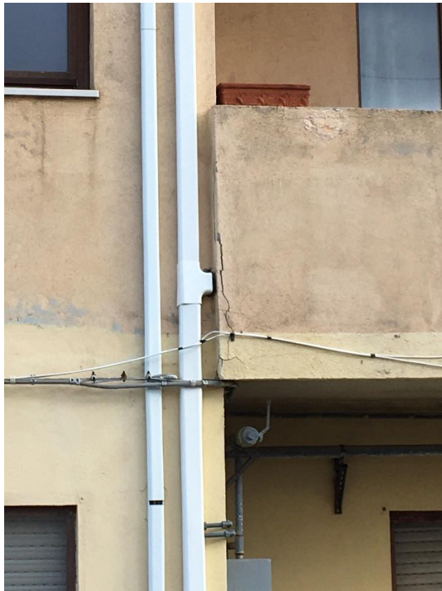
Foto 12 - Dettaglio di balcone
