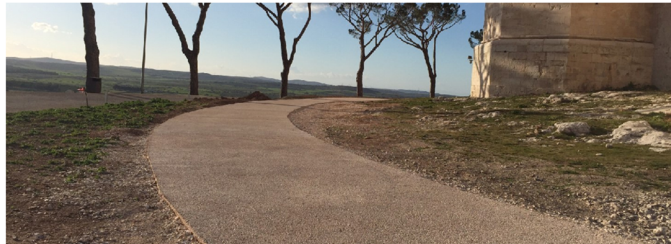
Pavimentazione in terra stabilizzata
