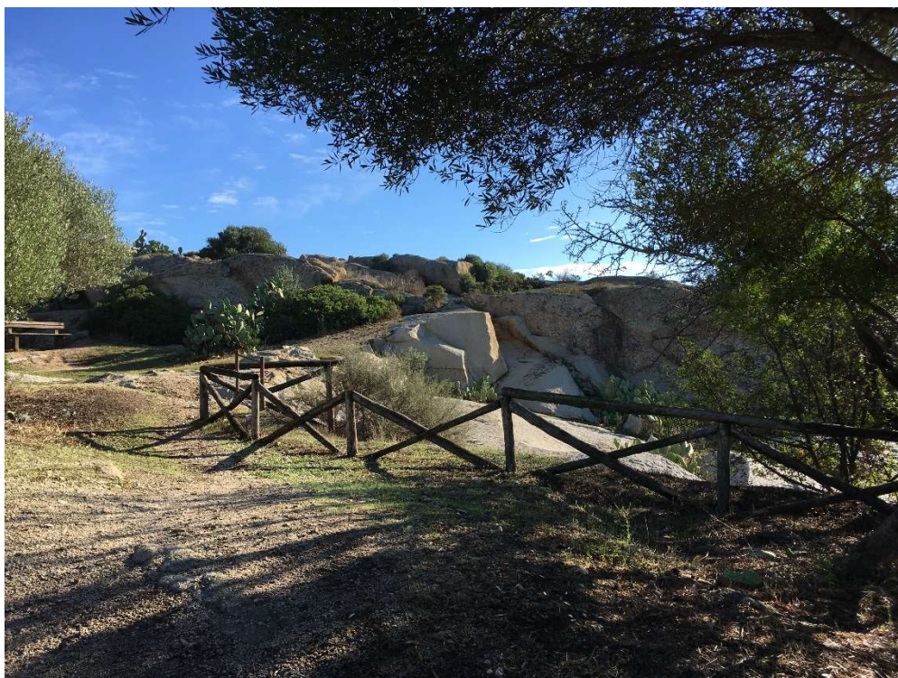
Foto 3 - Staccionate esistenti da revisionare
