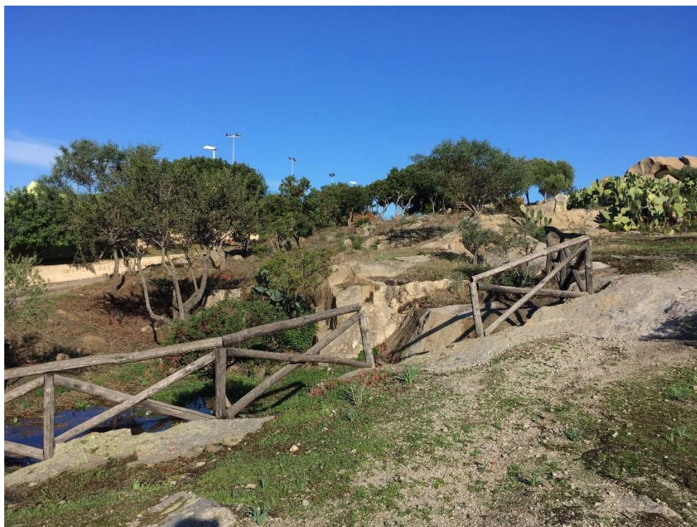
Foto 2 - Staccionate esistenti da revisionare
