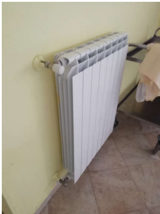
Foto 12 radiatore tipo esistente in alluminio
