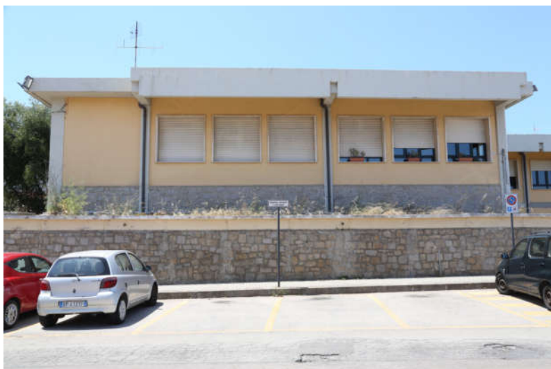
Foto 3 vista dal fronte est - via Del Faro
