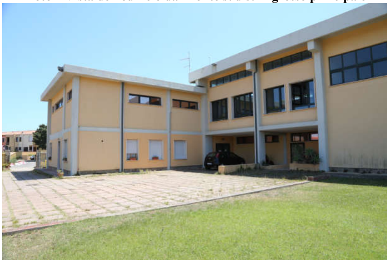
Foto 2 vista dal fronte sud - ingresso palestra
