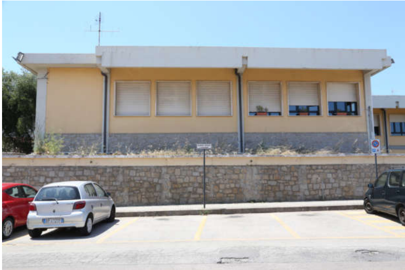
Foto 3 vista dal fronte est - via Del Faro
