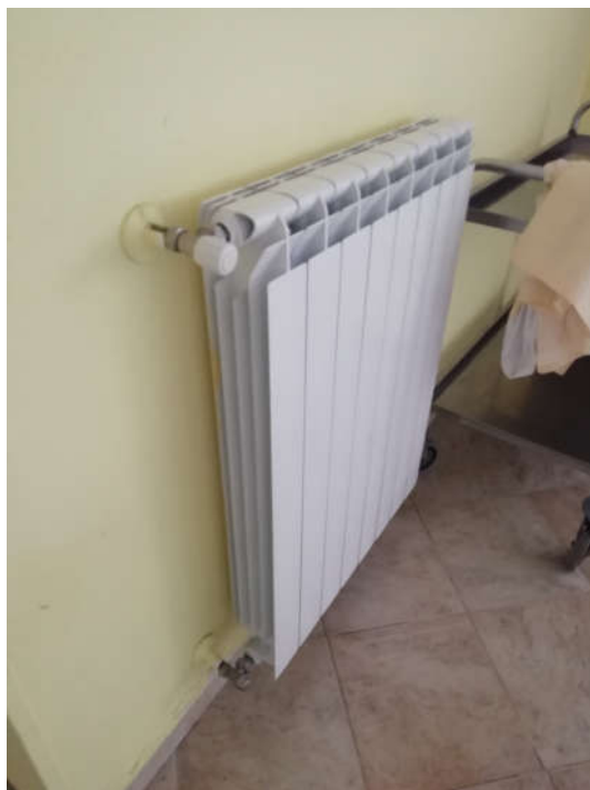
Foto 12 radiatore tipo esistente in alluminio
