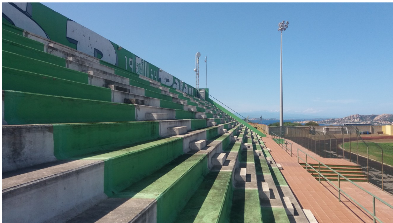
Fig. 8 – vista della tribuna verso NORD OVEST
