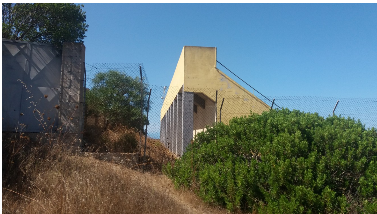
Fig. 9 – vista di scorcio della tribuna da NORD OVEST; pilastri che sorreggono la parte sommitale della tribuna
